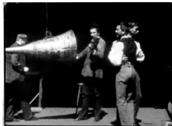
IMMAGINE 2: Fotogramma della prima sperimentazione di film sonoro fatta dal gruppo di ricerca di Edison (1894): il suono del violino è convogliato nell'imbuto di un fonografo
